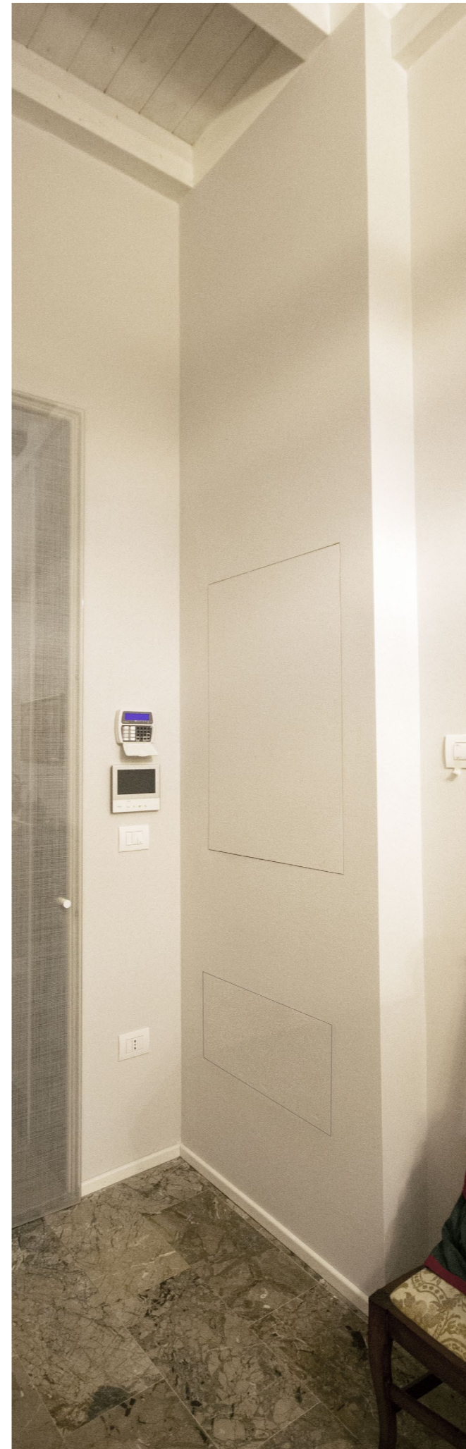
F35 per chiudere due scatole di derivazione già installate. F35 to close two junction boxes already installed.
