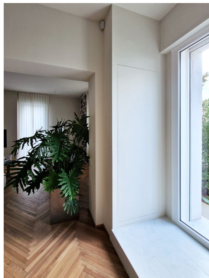
[1] Fantasmino ad un'anta in MDF con asta raddrizzante apertura push pull, per chiusura ripostiglio lato camino. | Fantosmino with one MDF door with straightening rod for push-pull opening, for closing the fireplace side closet.
