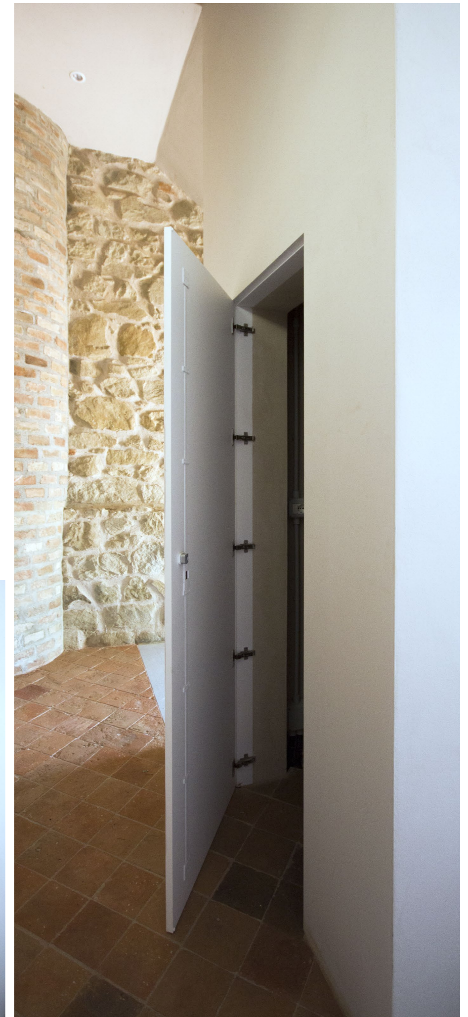
T100 a due ante battente in MDF con maniglia Made Filo ed asta raddrizzante per ripostiglio pianerottolo scala.
