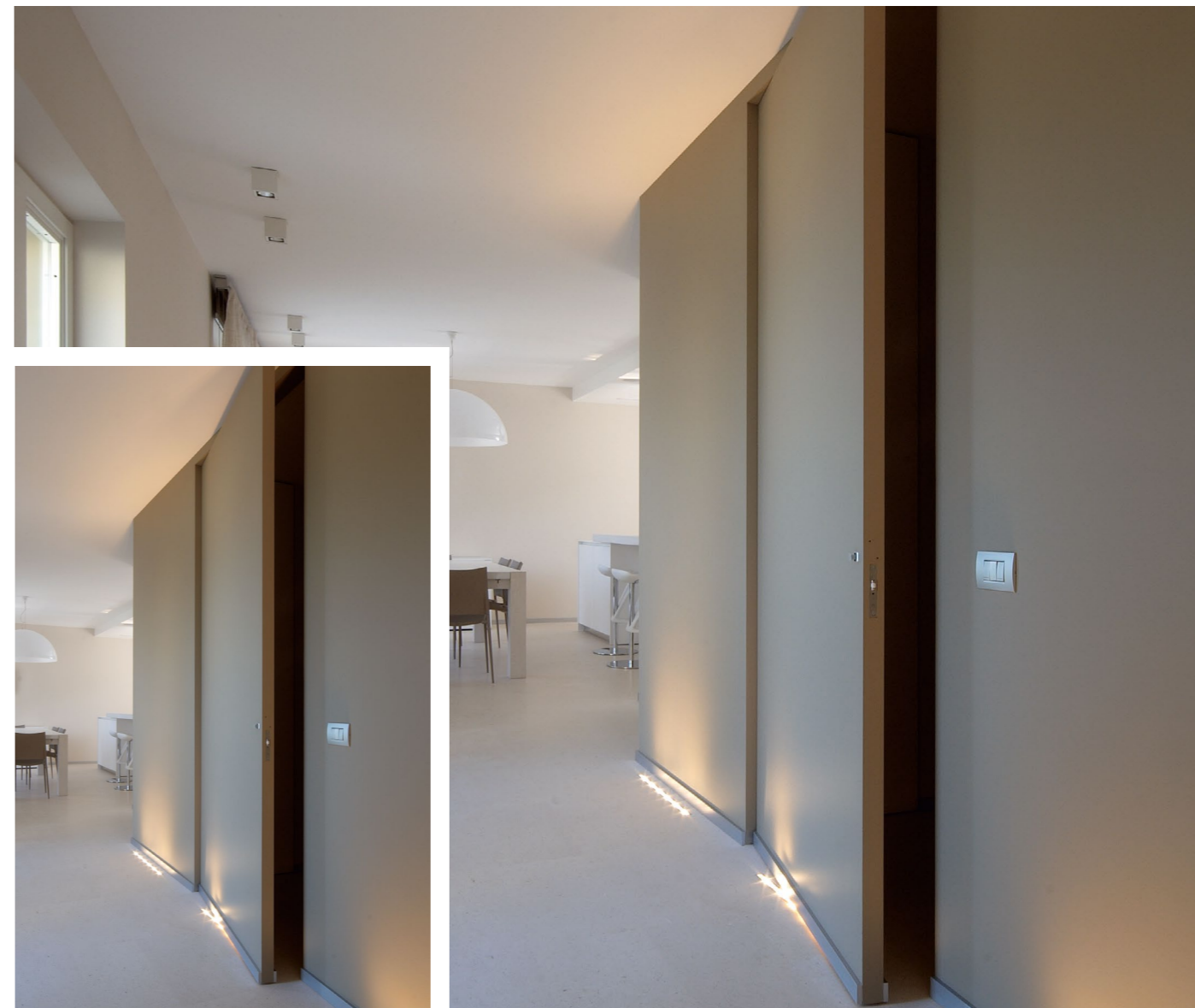
Porte a bilico con stipite a tutto spessore ad anta singola e ad anta doppia. Pivot doors with full-thickness frame in single and double panel versions.
