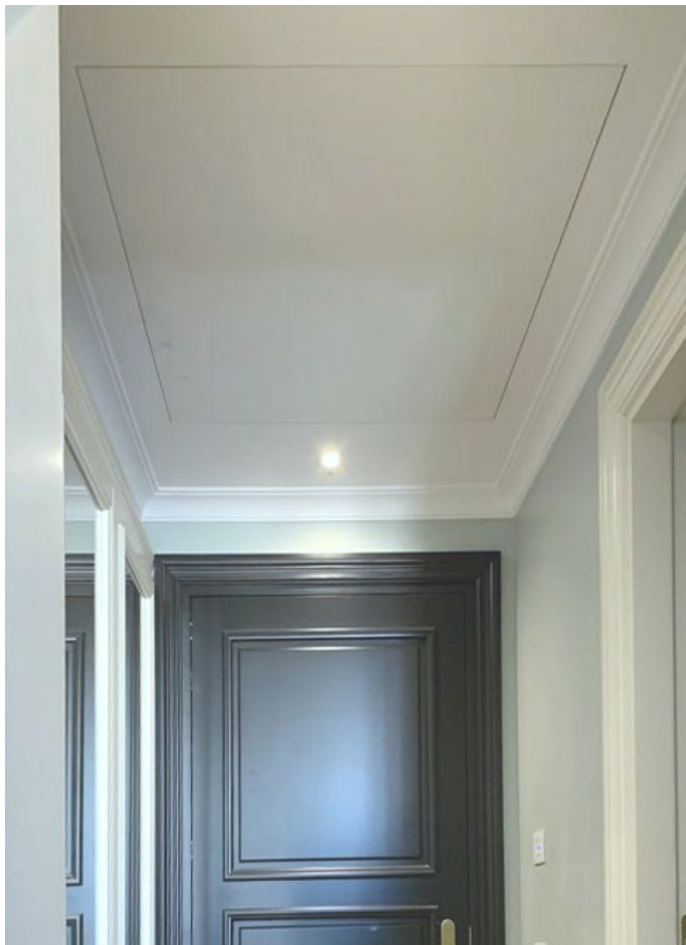
Botola B57 a soffitto anta in SA con lavorazione persiane per mandata-ripresa aria più kit cavetto di sicurezza, per macchinari posizionati in un disimpegno. | Trapdoor B57 in SA door with shutters processing for air supply, for machinery located in a hallway plus safety cable kit.
