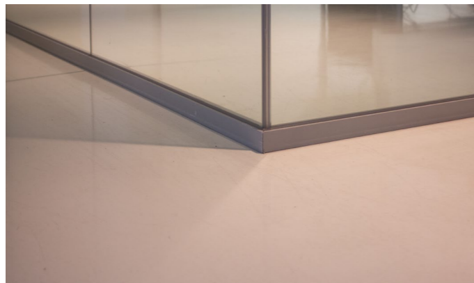
Lastra applicata nel profilo Wall B a pavimento. Slab applied in the Wall B profile at floor level.
