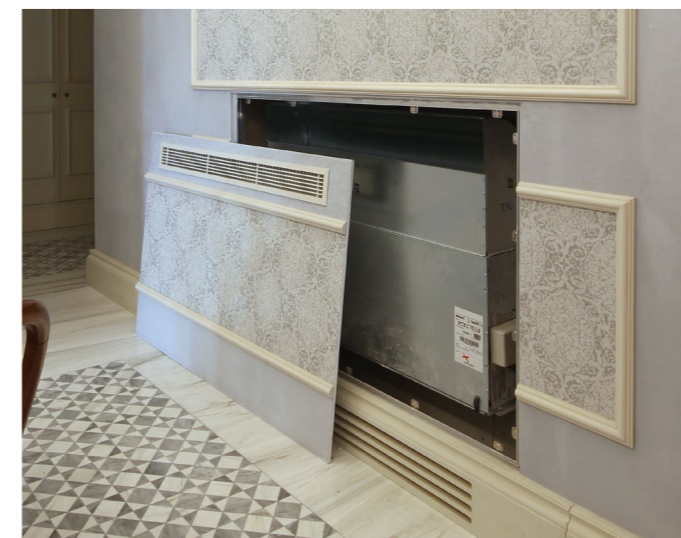
Faint Heavy rivestito con boiserie di tappezzeria e cornici, per ispezionare termoconvettore incassato. | Faint Heavy covered with upholstery paneling and frames, to inspect the built-in convector.
