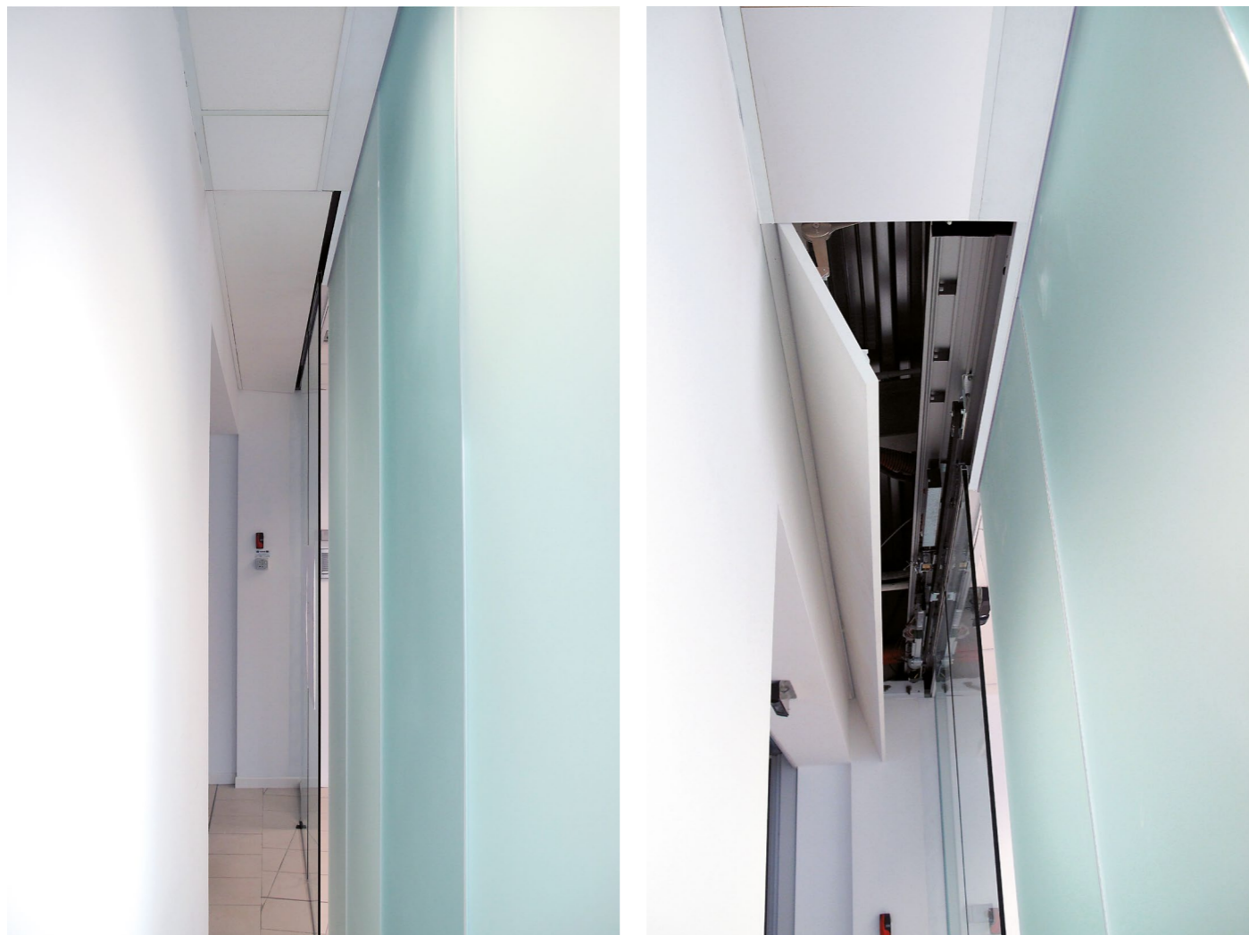
Botola Fantasmino anta S.A. (stratifica di alluminio) con stipite speciale su tre lati e traverso rientrante per ispezione scorrevoli automatici a soffitto.
