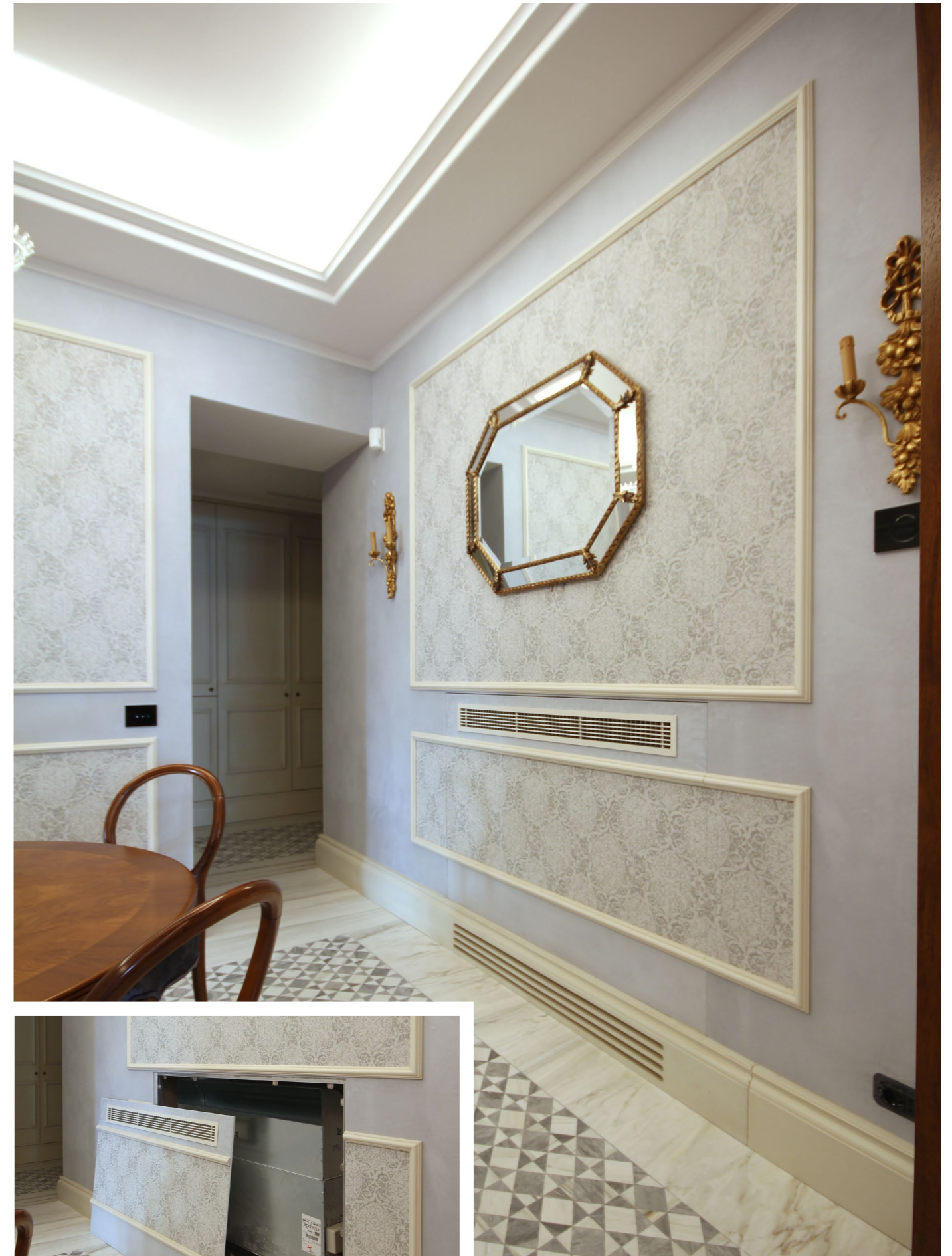
Faint Heavy rivestito con boiserie di tappezzeria e cornici, per ispezionare termoconvettore incassato. | Faint Heavy covered with upholstery paneling and frames, to inspect the built-in convector.
