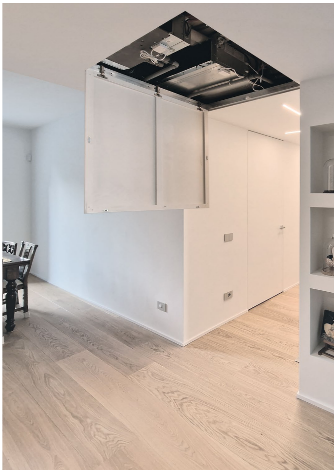
Botola B57 a soffitto anta in SA e kit cavetto di sicurezza, per macchinari posizionati in un disimpegno di una camera di albergo. Trapdoor B57 to soffitto door in SA and safety cable kit, for machinery located in a hallway of a hotel room.
